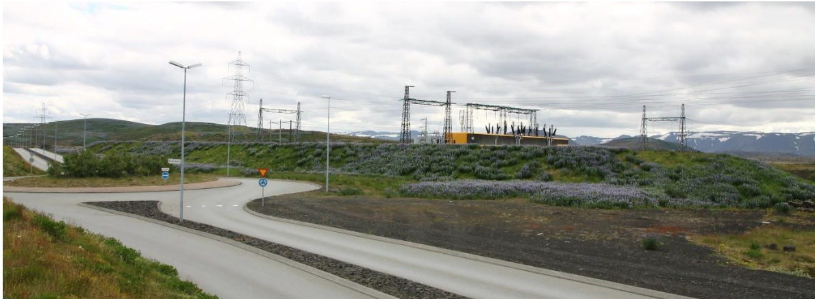
3. mynd. Skýringarmynd – horft frá Hamranesvirki til norðausturs. Mynd greir grein fyrir legu Ásvallaþrautar og Hamraneslínu meðfram henni.
